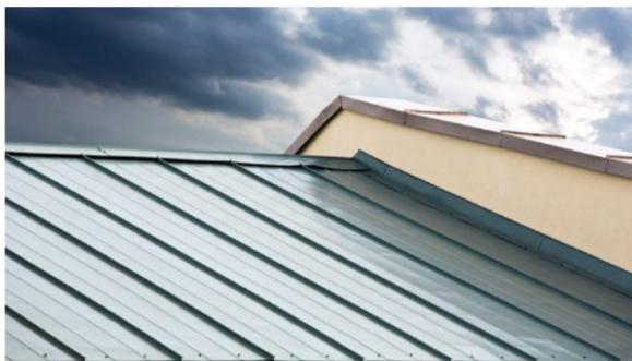
El Panel Sándwich está compuesto por un núcleo interno aislante de espumas rígidas de Poliuretano (PUR), Polisocianurato (PIR) o lana mineral envueltas por dos láminas conformadas de distintos materiales y espesores según el uso y el entorno donde se vaya a instalar.
